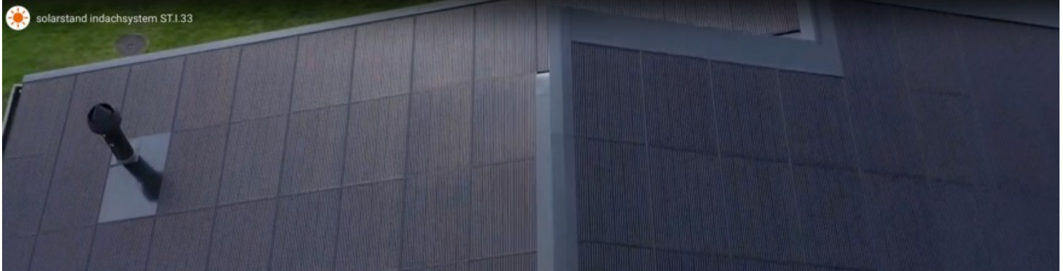
Solarstand ST.1.33 Indachsystem für gerahmte Standard PV-Module, Evang. Kirche, Steinach - 82 kWp
